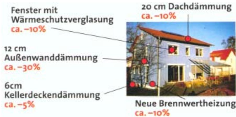
**Abb. 1-8** : Energiespareffekte verschiedener Dämmmaßnahmen.
