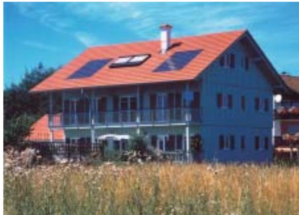
**Abb. 1-2 :** PV-Module in Indachmontage. Foto: Braas.
